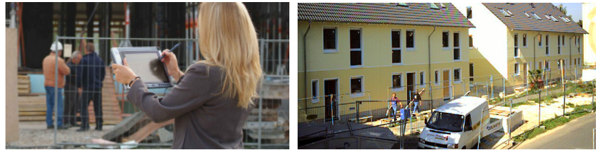
Abbildung: mobile Erfassung des Baufortschritts direkt auf der Baustelle
