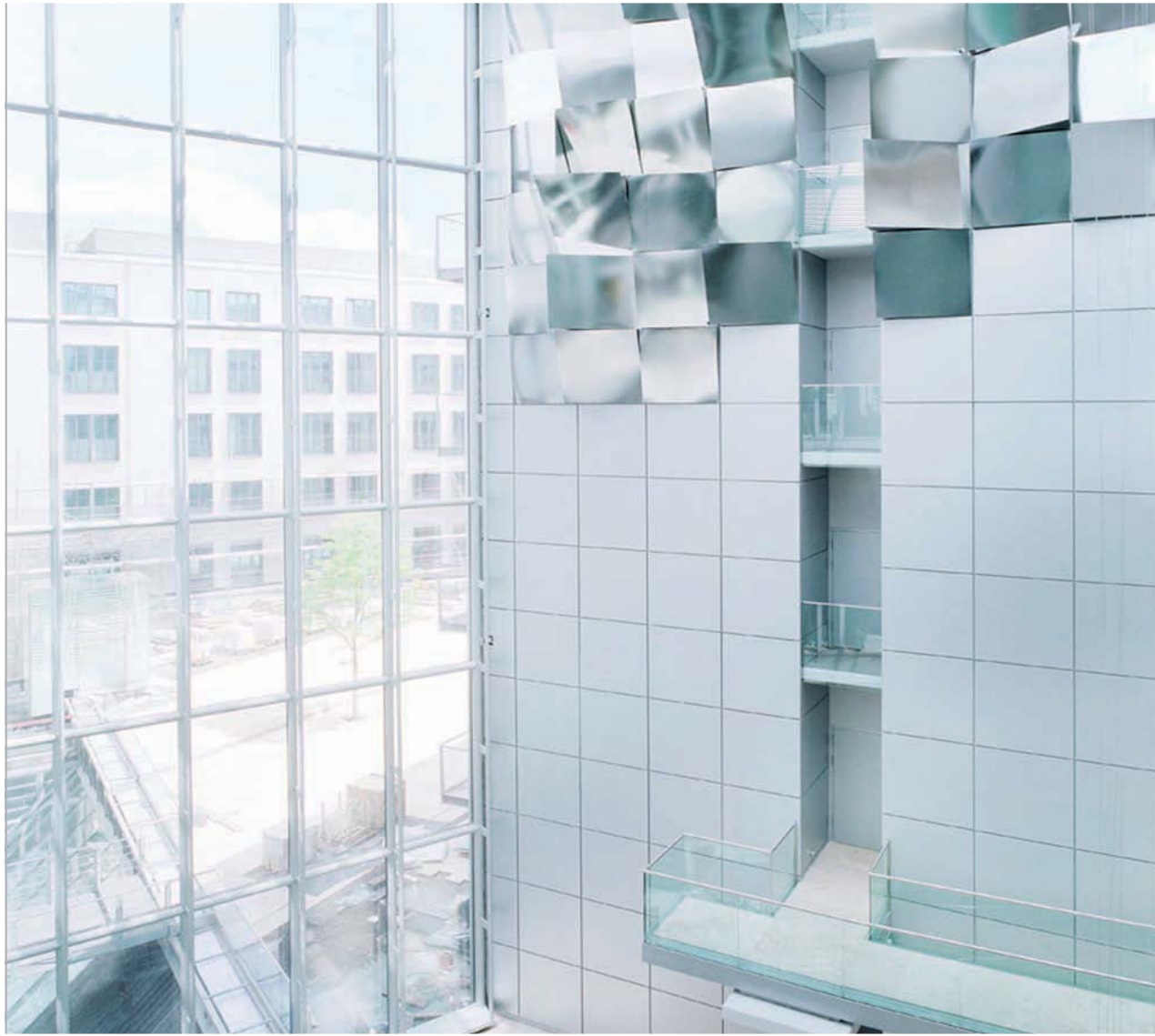
E.ON Energie AG Konzernzentrale, München
